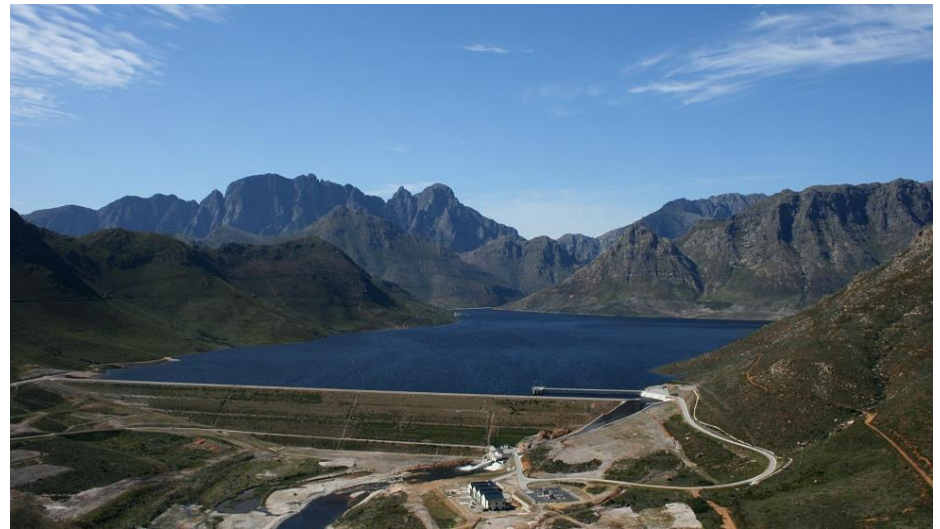
Berg River Dam
